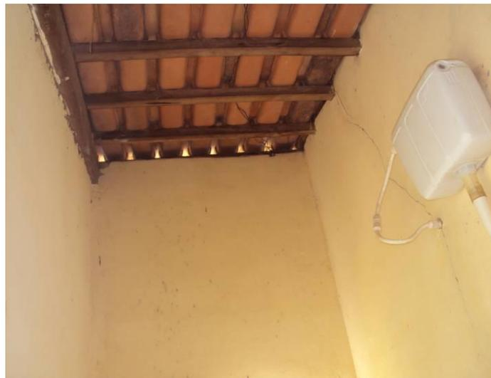
O **banheiro 2** está com as louças seminovas. O revestimento de piso e paredes está manchado. As torneiras estão em funcionamento assim como a bacia sanitária. A porta de madeira está em péssimo estado não sendo adequada para o local. A janela está sem os vidros, um pouco corroída e a pintura desgastada. Não existe forro de teto nem luminária, apenas a lâmpada no soquete. O Box do chuveiro não tem separação por portas ou parede e está sem o chuveiro.
