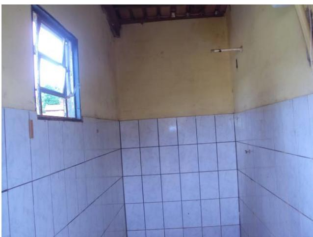
O **Vestiário** não tem piso cerâmico, possui um banco contínuo de alvenaria de 30 cm de largura, não tem forro no teto, não tem tomadas elétricas, nem local para guarda de objetos. A porta de madeira está em péssimo estado não sendo adequada para o local. A janela está sem os vidros, um pouco corroída e a pintura desgastada. Não existe forro de teto nem luminária, apenas a lâmpada no soquete.
