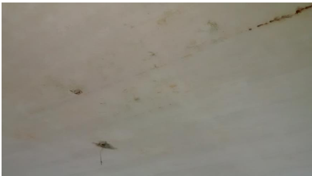
Foto 04: Pintura danificada ;
