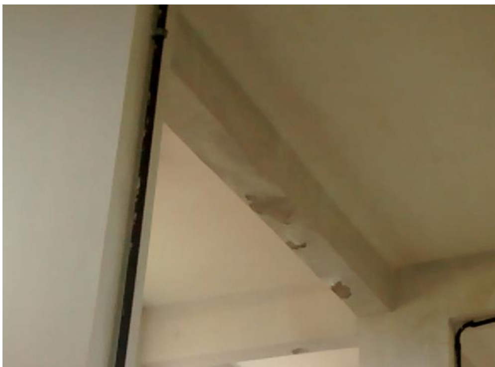
Foto 05: Pintura danificada ;
