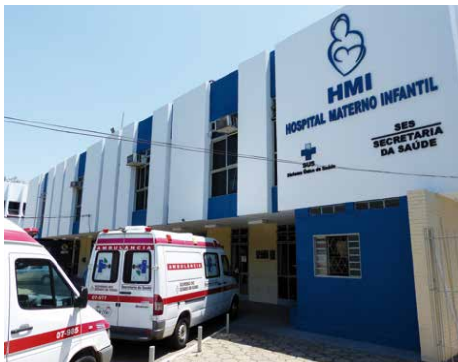
Hospital Materno-Infantil: unidade ganha nova pintura e revitalização da fachada
