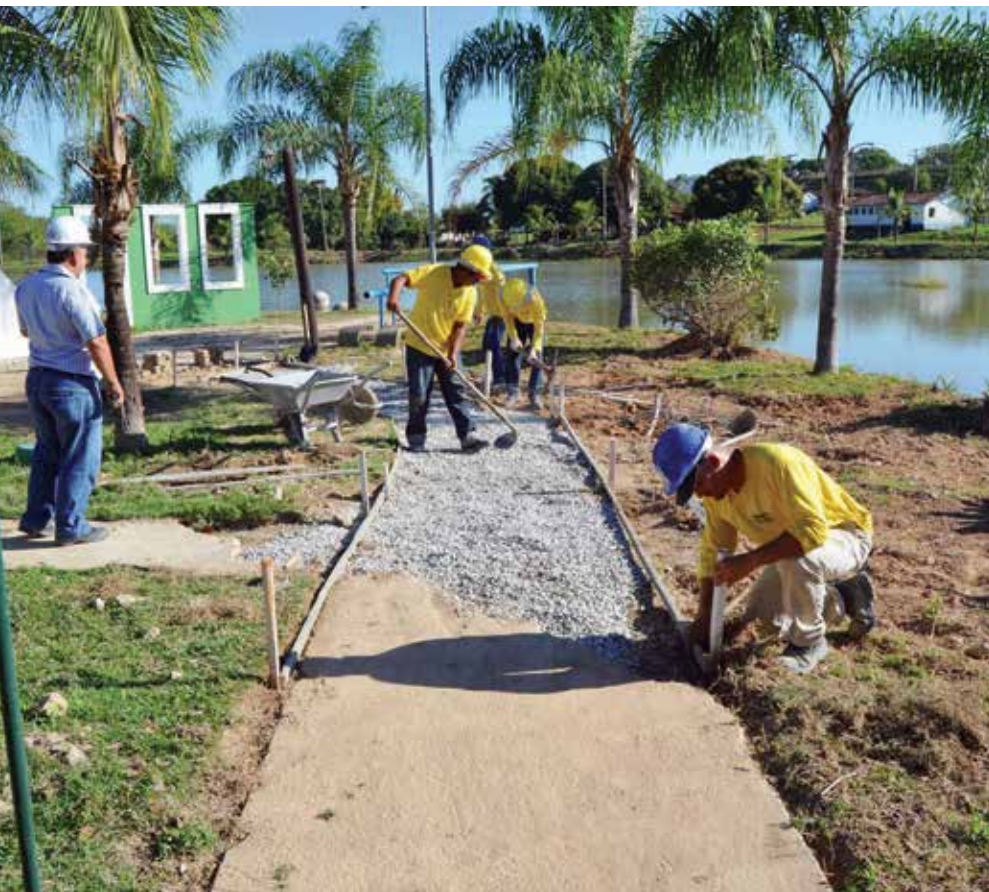
Lago das Acácias, na Cidade de Goiás, sendo construído para garantir mais lazer à população
