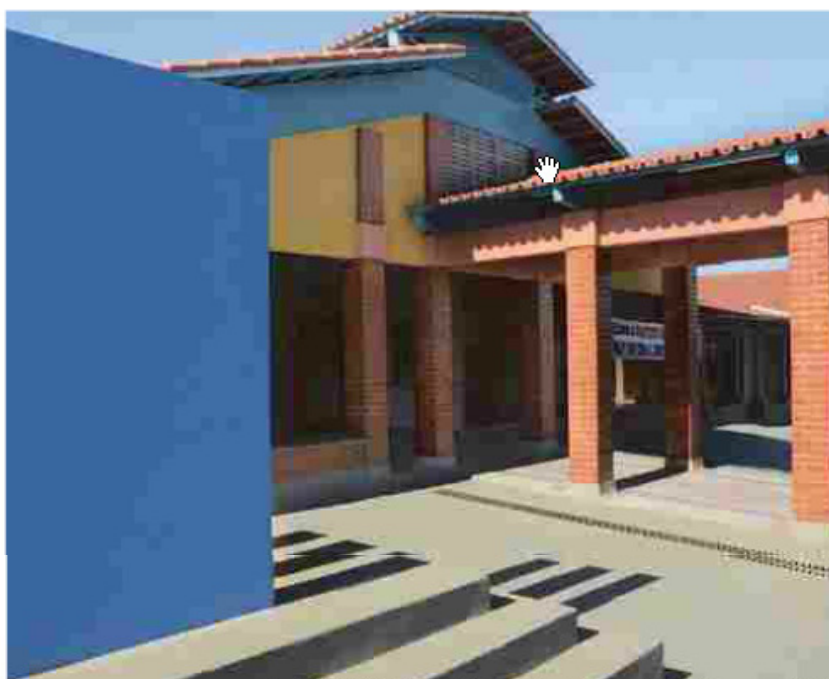
Escola Padrão Século XXI em Anápolis, construída pelo Governo de Goiás, entregue no ano de 2014
