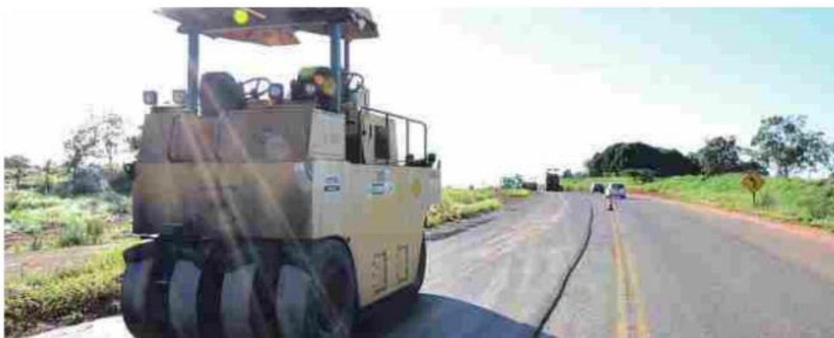
Máquinas em ação na GO-020, entre Bela Vista de Goiás e Pires do Rio; rodovia foi reformada e duplicada no trecho metropolitano de Goiânia
