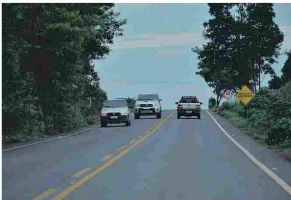
Trecho reconstruído da rodovia GO-324, obra fundamental para dinamizar a economia da região do Oeste Goiano
