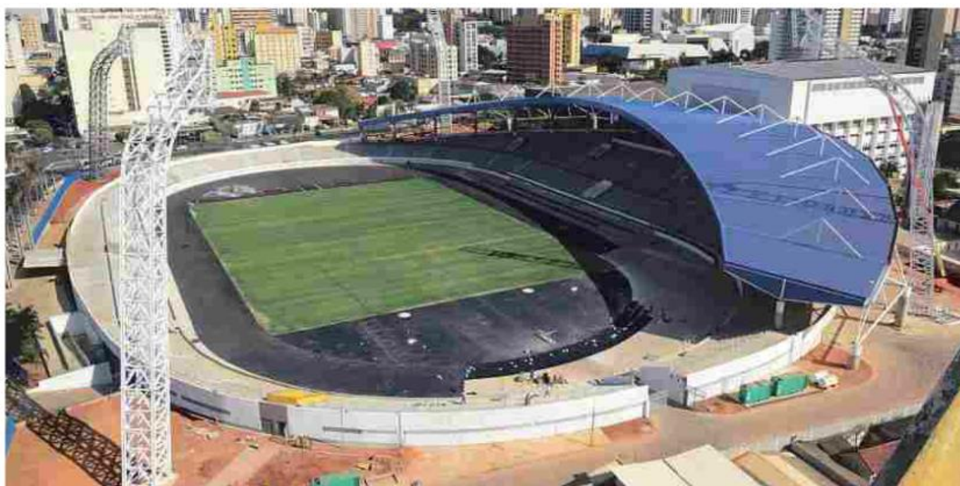
Com nova cara e completamente reconstruído, Estádio Olímpico terá capacidade para 12 mil pessoas sentadas e completa estrutura para treinamento de atletas olímpicos
