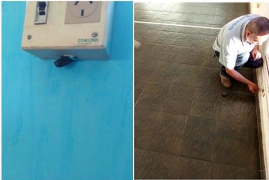
*Figura 5 - Isolamento dos fios elétricos expostos*
