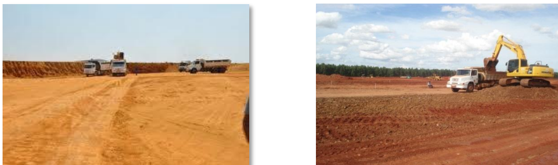
Figura 22 – Fotos da obra do aeroporto de carga de Anápolis. Fonte: Deloitte
